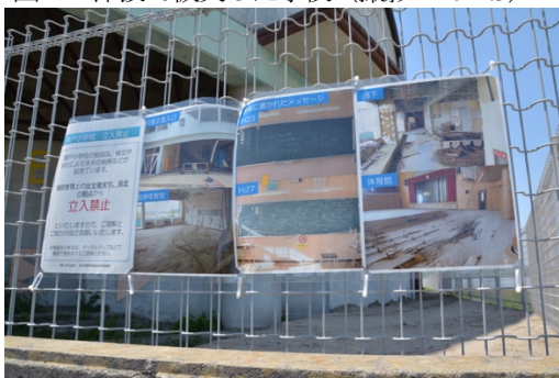
図2 津波で被災した小学校（撮影：2017.5）
